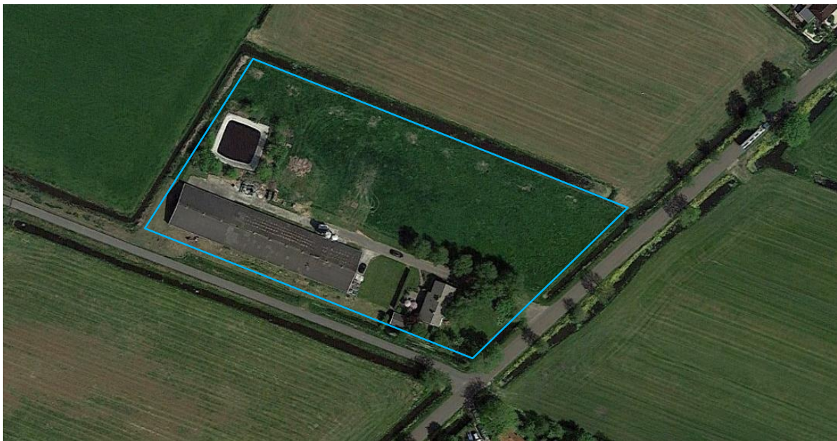
Locatie Hoofdweg 36 vanuit de lucht situatie 2021, met te slopen stal en mestopslag. (Bron: Google Earth)
