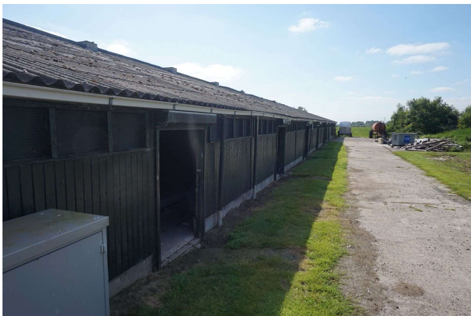
Figuur 2.2 Aanzicht te slopen schuur
