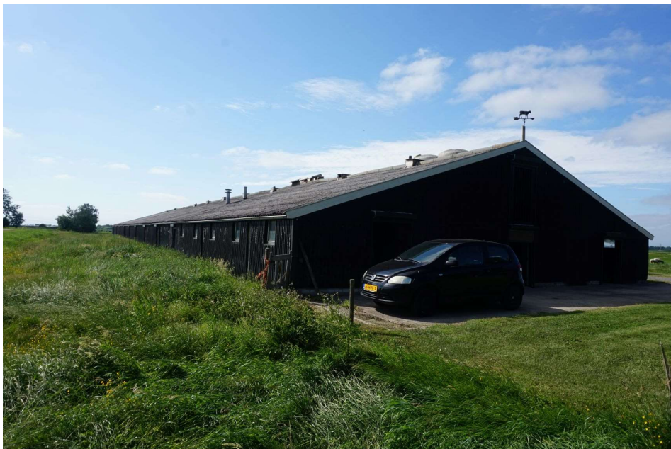
Figuur 2.1 Aanzicht te slopen schuur
