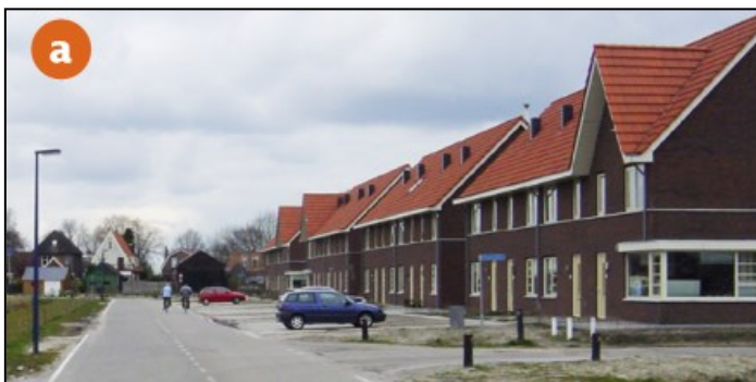
De rijwoningen van woonsfeer 1a, gezien vanaf de Grote Vuurvlinder ter hoogte van het nieuwe blok van woonsfeer 1e-I, dat in het verlengde van deze rij wordt gebouwd.
