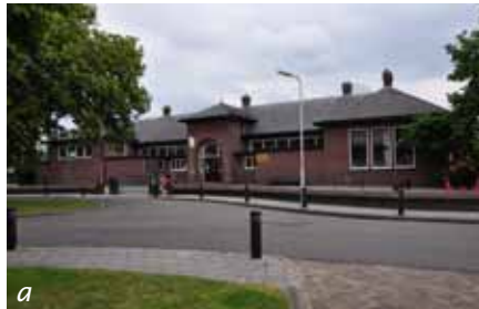
deelgebied 2: a. Tuindorp school aan de Linde b. laan en de Eikenlaan
