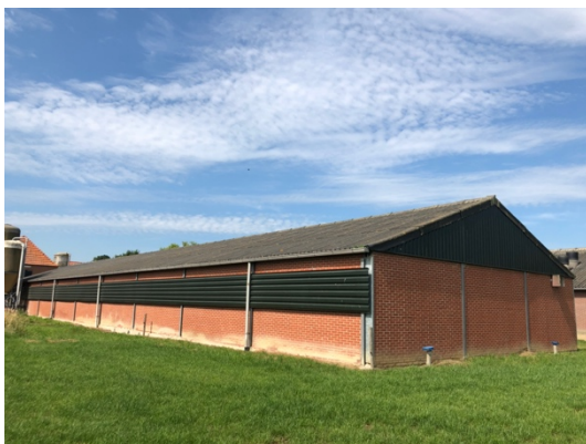
Sta nr. 2, achteraanzicht
