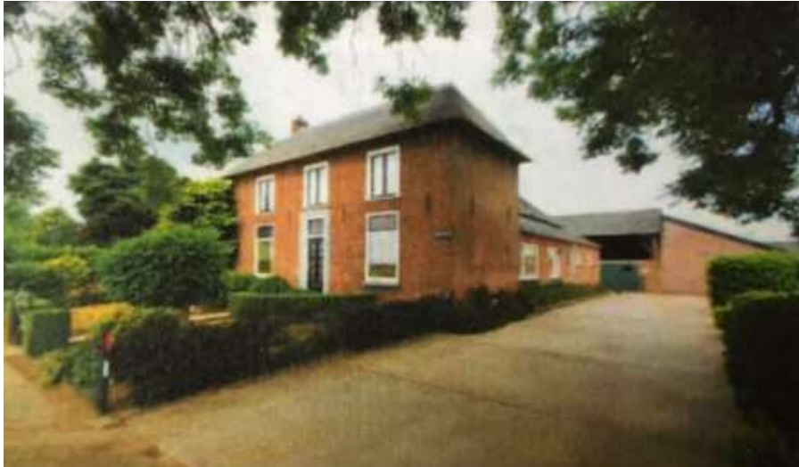
Afbeelding 1: De kapschuur is herbouw op de plek van de voormalige kapschuur (d.d. 2015).
