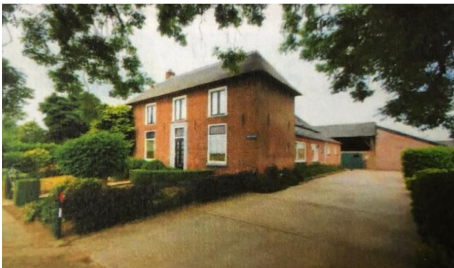
Foto 1: De kapschuur is herbouw op de plek van de voormalige kapschuur (d.d. 2015).
