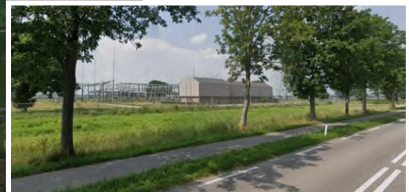
Huidig onderstation en schakeltuin
