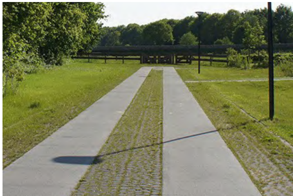
De nieuwe toegangsweg oogt ondergeschikt aan de hoofdtoegang door deze uit te voeren als een karrenspoor profiel, bestaande uit stelconplaten en grasbetontegels (bron beeld: Urhahn)
