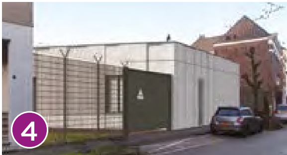
Foto van beton-uitvoering (links) en impressie van standaard onderstation uitgevoerd in betonelementen (rechts).
