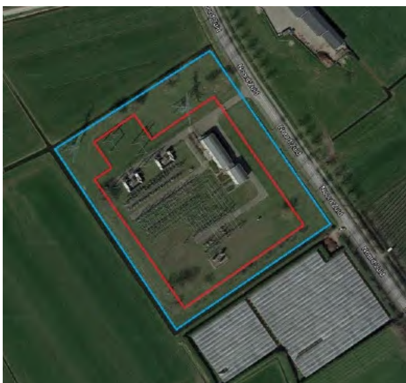
Figuur 1 (links): Luchtfoto transformatorstation Druten. Blauw: eigendom Liander NV. Rood: Hekwerk rondom station.
