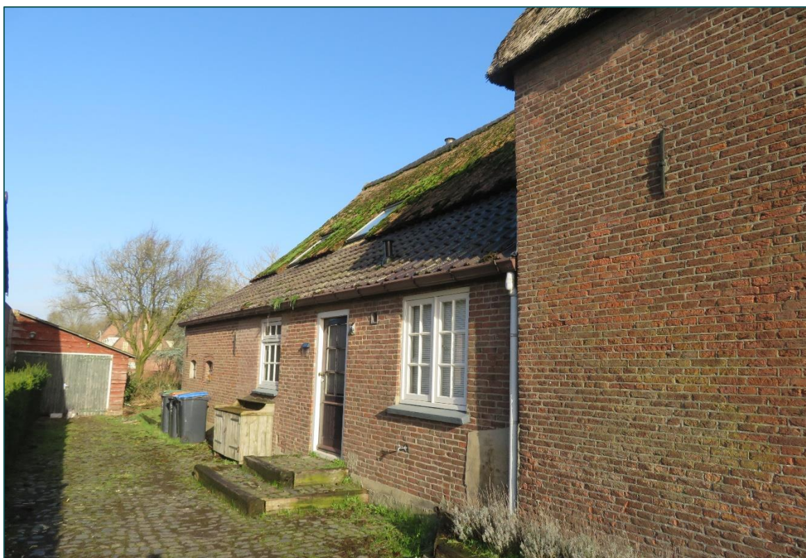
Figuur 2 De bebouwing bestaat uit bakstenen muren zonder spouw en een dak van riet en dakpannen.
