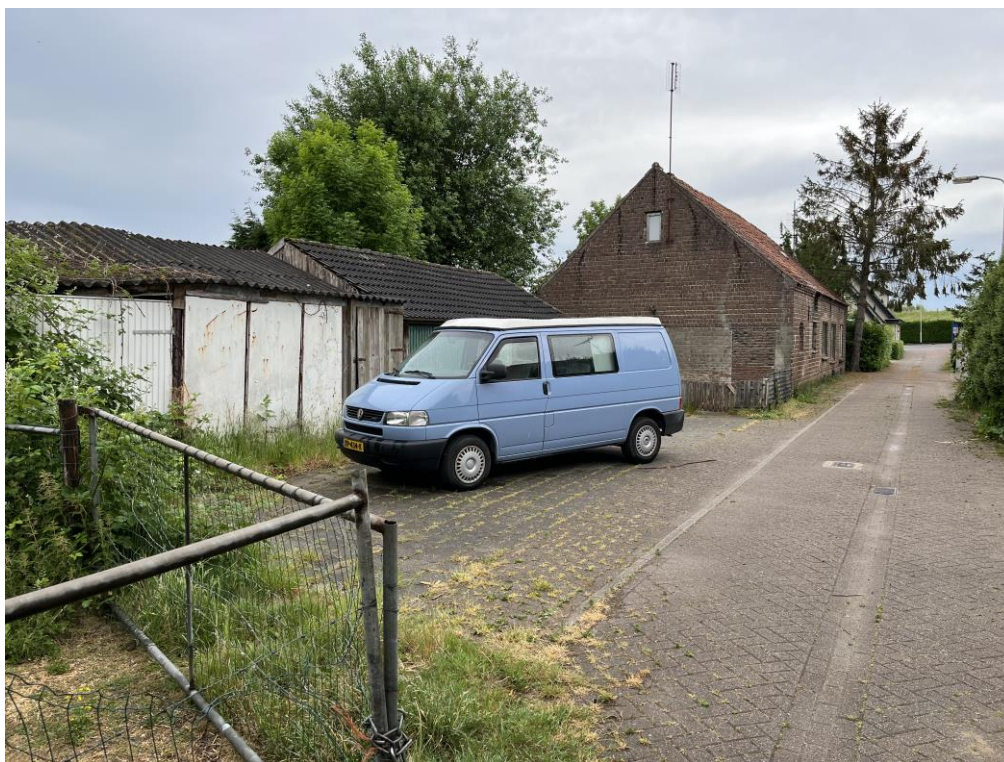
Voorzijde te slopen woning met bijgebouwen aan de Stationsstraat 77
