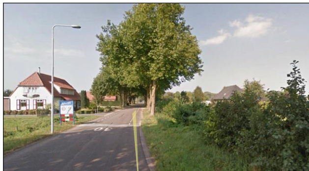
De Koningstraat t.h.v. het plangebied in westelijke richting
