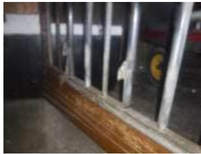
Aanzicht aftimmering onderzijde asbesthoudend dakbeschoot en voormalige stalinrichting
