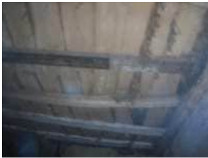
Aanzicht aftimmering onderzijde asbesthoudend dakbeschoot en voormalige stalinrichting
