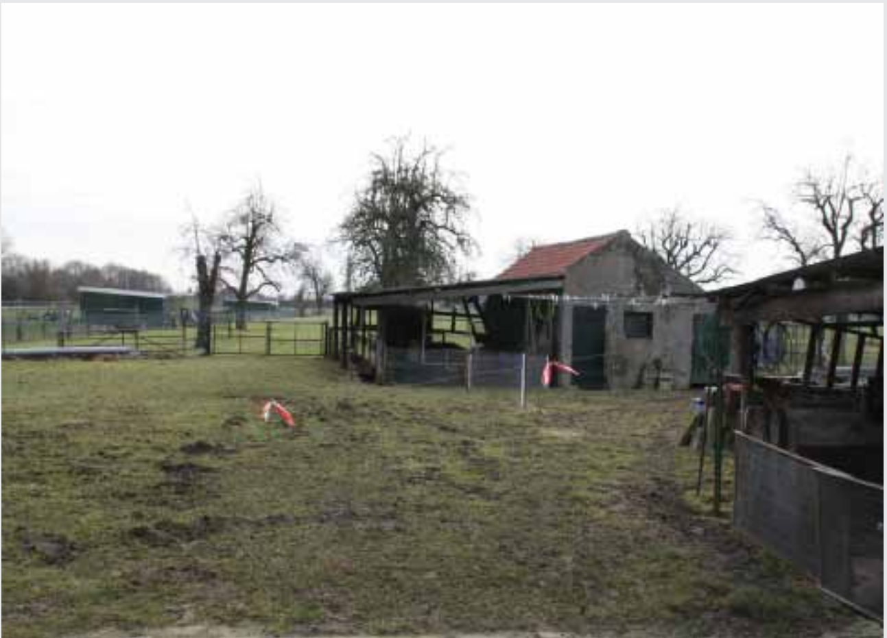
Figuur 5 Te slopen bebouwing
