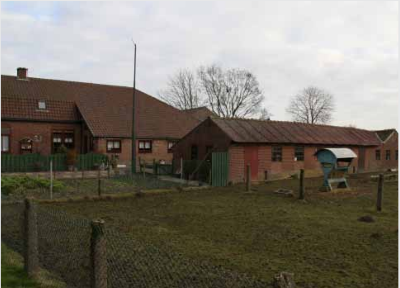
Figuur 6 Klapstraat 5 en bouwlocatie
