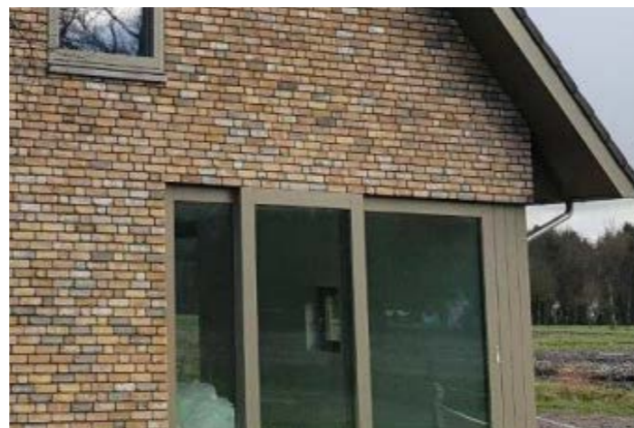
► Houtwerk in één gedekte kleur, in harmonie met steen
