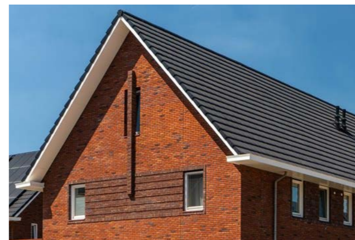
► Toepassen verschillende metselverbanden
