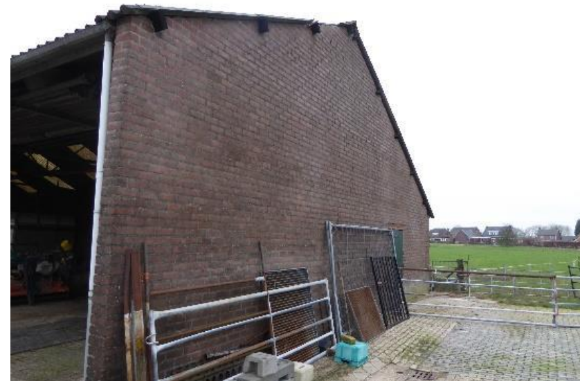
Figuur 5: Westzijde van de schuur
