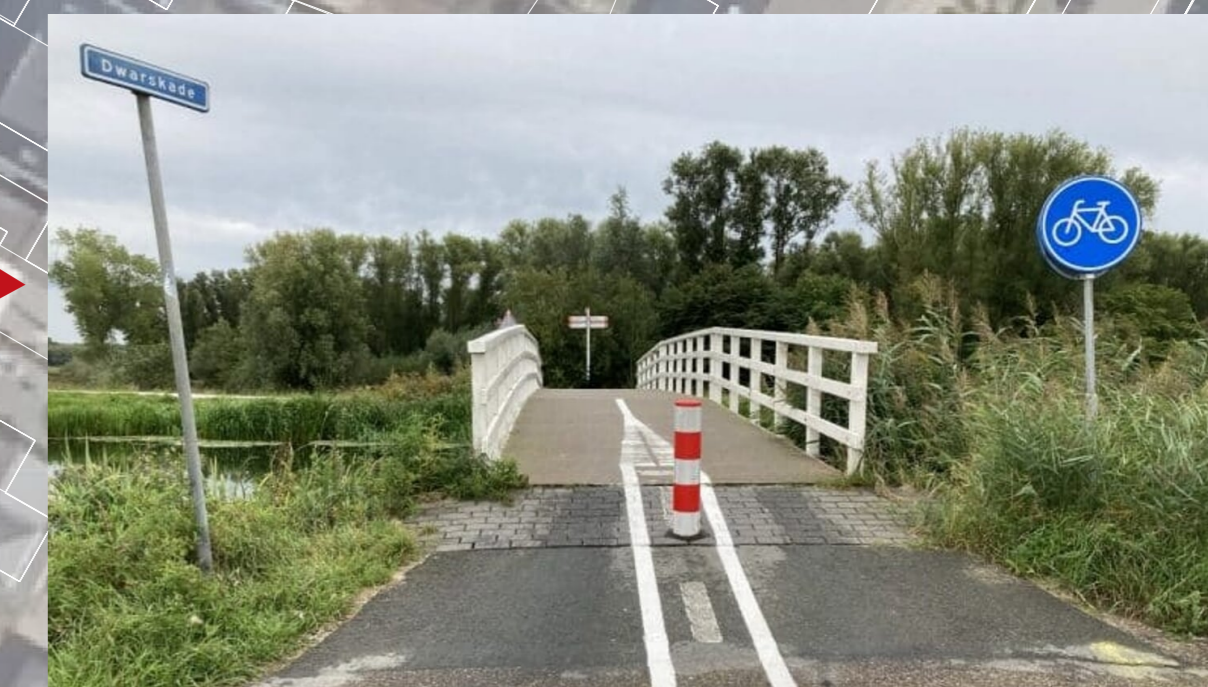
Een tweede aansluiting op de Driemorgen voor langzaam verkeer (voetgangers/fietsers) door middel van een extra duiker. Dankzij een paaltje in het midden kunnen indien nodig hulpdiensten passeren (extra calamiteitenonthoofding).
