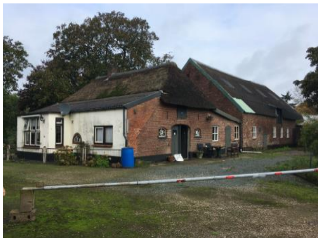
Oorspronkelijke Boerderij Hogeweg 4 en aangebouwde stal A
