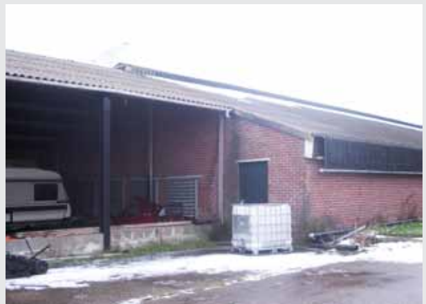
Open kapschuur voor zagen en kloven' Laarstraat 9, achterzijde
