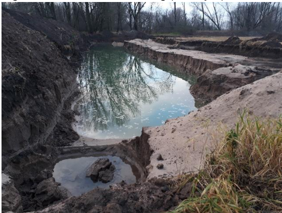
Figuur 2.6: Recente graafwerkzaamheden
