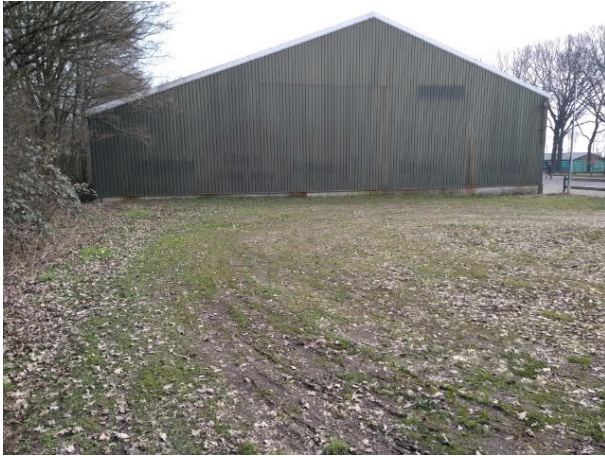
Foto 25: Uitloopbak manege (verhard met menggranulaat)
