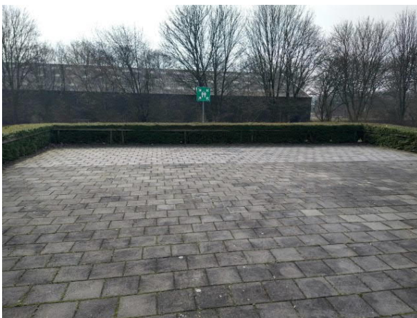
Foto 20: Tegelerharding achter het zwembad
