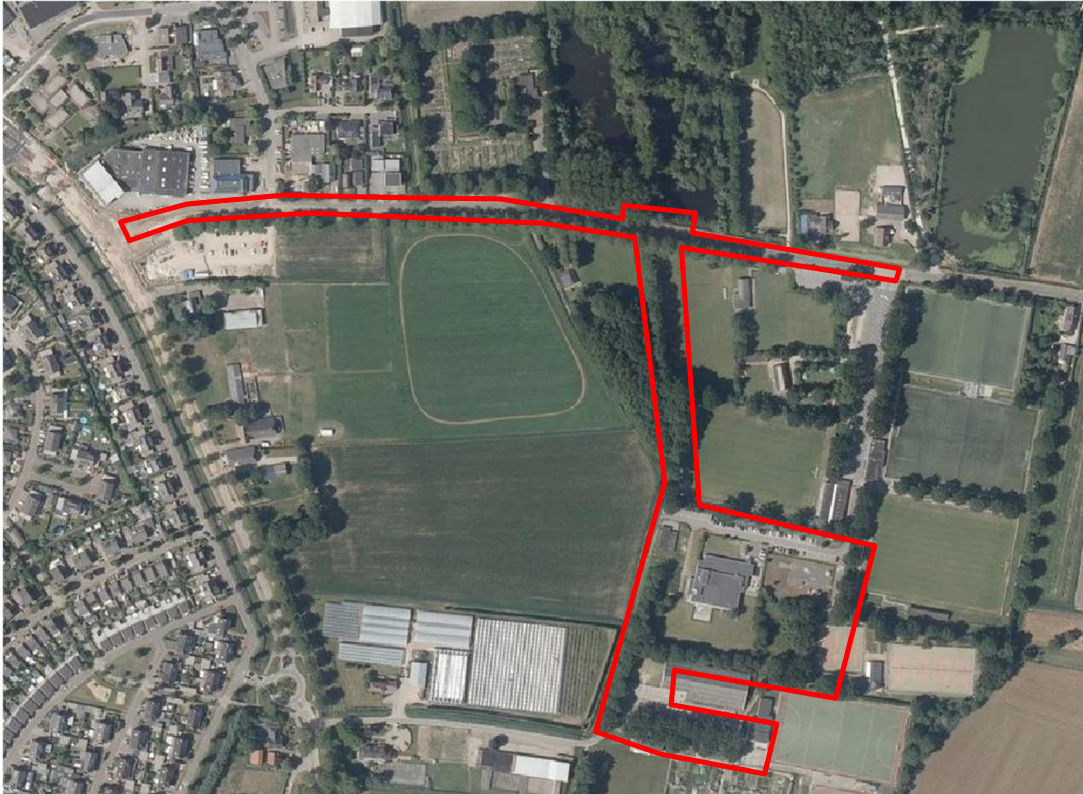
Afbeelding 1: Luchtfoto onderzoekslocatie (bron: www.pdok.nl)
