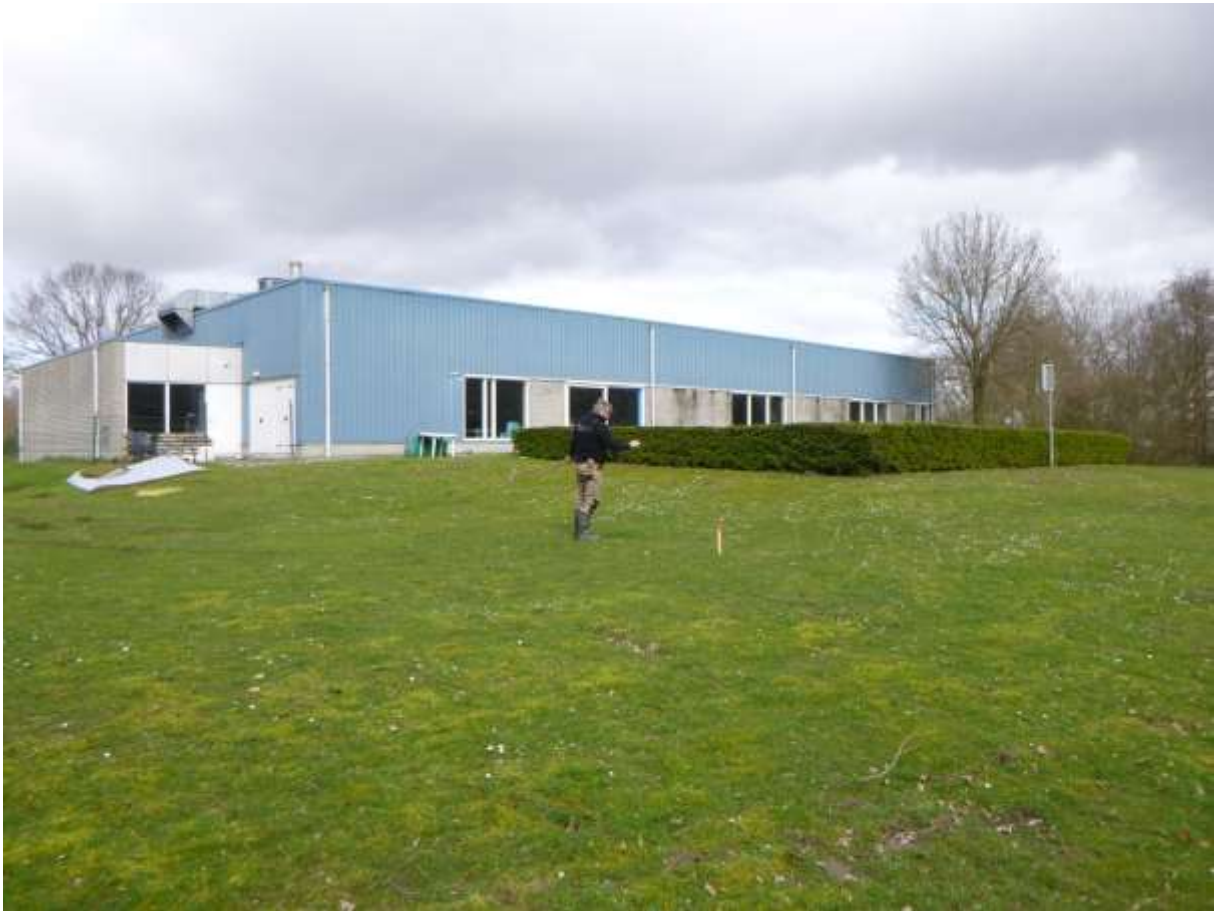
Figuur 18: Boren binnen het plangebied, gezien vanuit de zuidwesthoek van het plangebied in noordelijke richting
