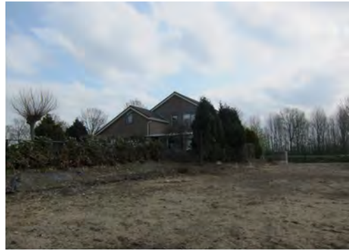
Bestaande woning Molenweg 33
