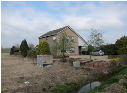
Bestaande woning Molenweg 33
