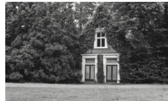
Zijgevel van het washuis in het park, 1978, A.J. van der Wal, Rijksdienst voor het Cultureel Erfgoed
