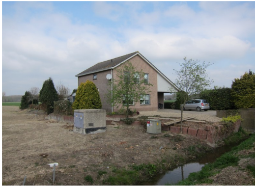
Bestaande woning Molenweg 33
