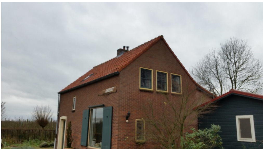
Figuur 5 De woning 'Karekiet' heeft potentiële verblijfplaatsen voor vleermuizen door onder andere de aanwezigheid van spouwmuren met open stootvoegen
