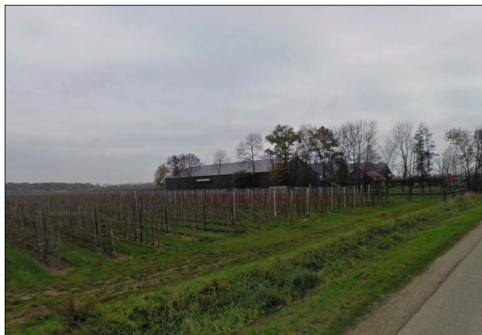
Situatie na bouw 1 e ring, maar voor realisatie van gebouw nr. 4 (bron: Google Earth)
