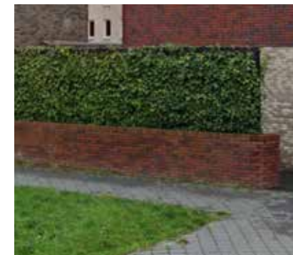
Muur met hekwerk en klimop
