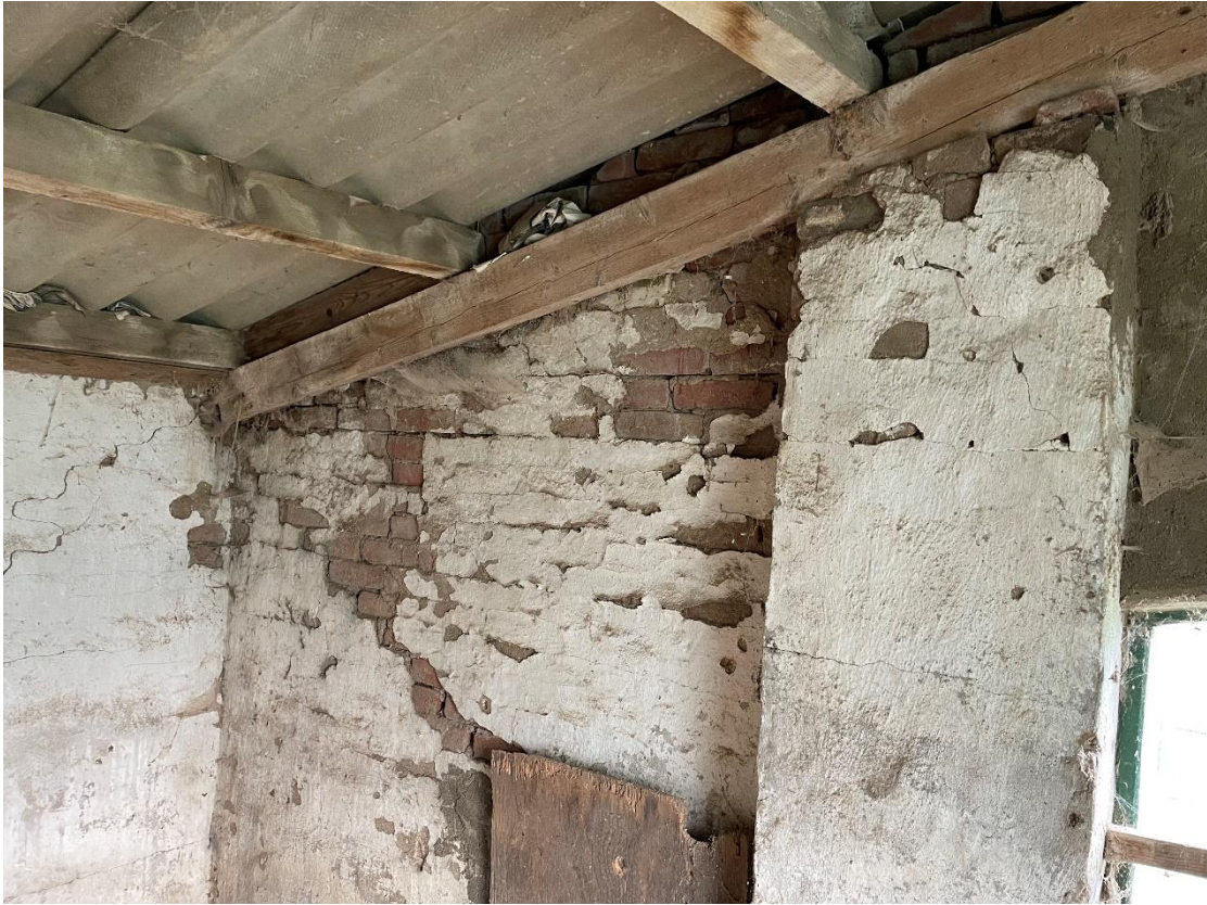
Foto 26: de schuur heeft steens gemetselde muren en een golfplaat als dak.
