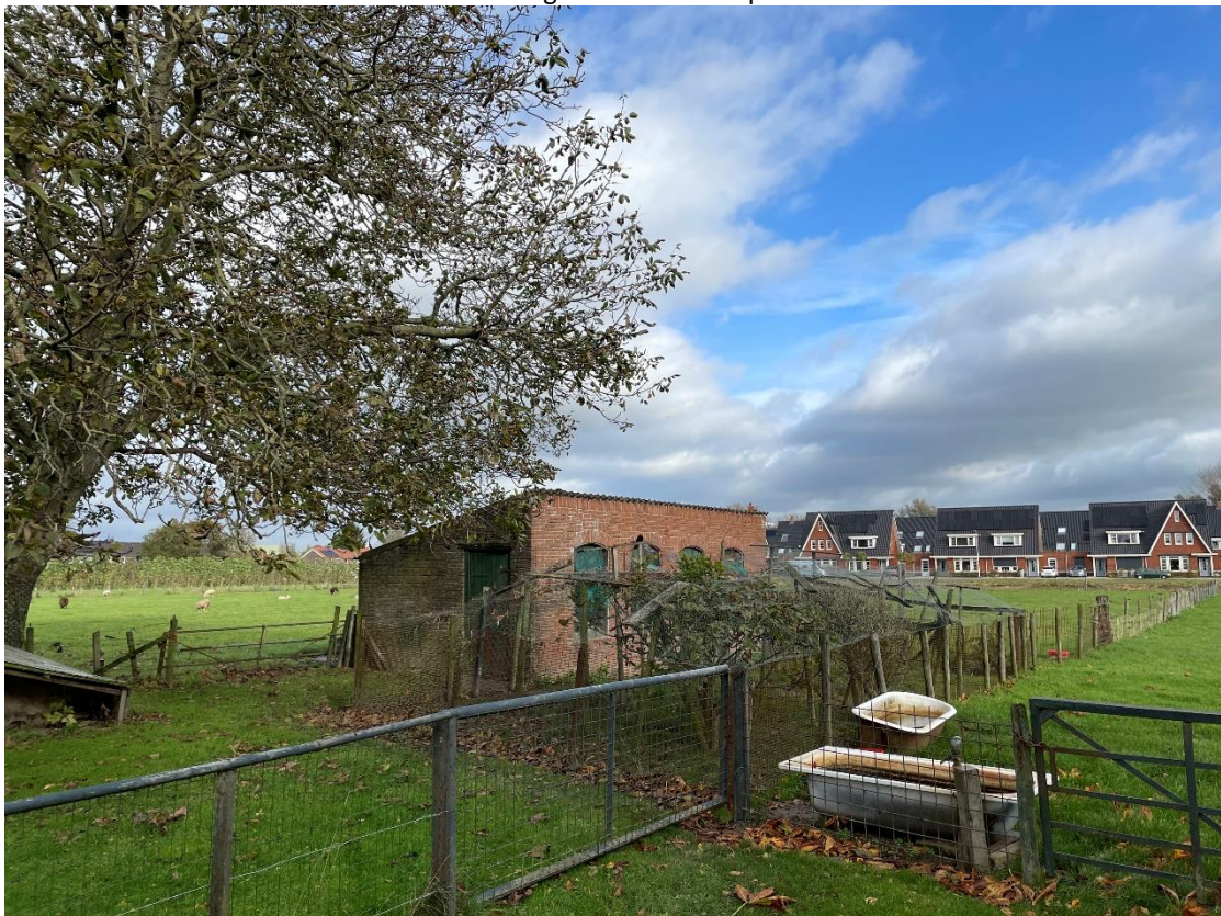
Foto 25: het te slopen schuurtje op deellocatie 5.
