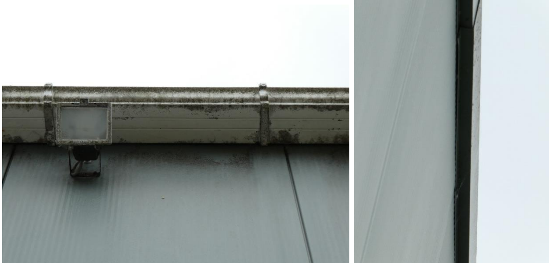
Afbeelding 11 en 12: geen openingen naar mogelijke verblijfplaatsen van vleermuizen aangetroffen. Gevels en daken bestaan uit geïsoleerde dakplaten en wanden. Bron: BNL advies. Datum: 26-07-2022
