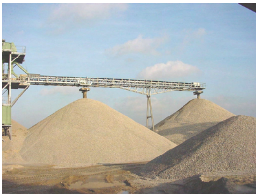
Figuur 8.6.2: Foto transportband (bij klasseerinstallatie)
