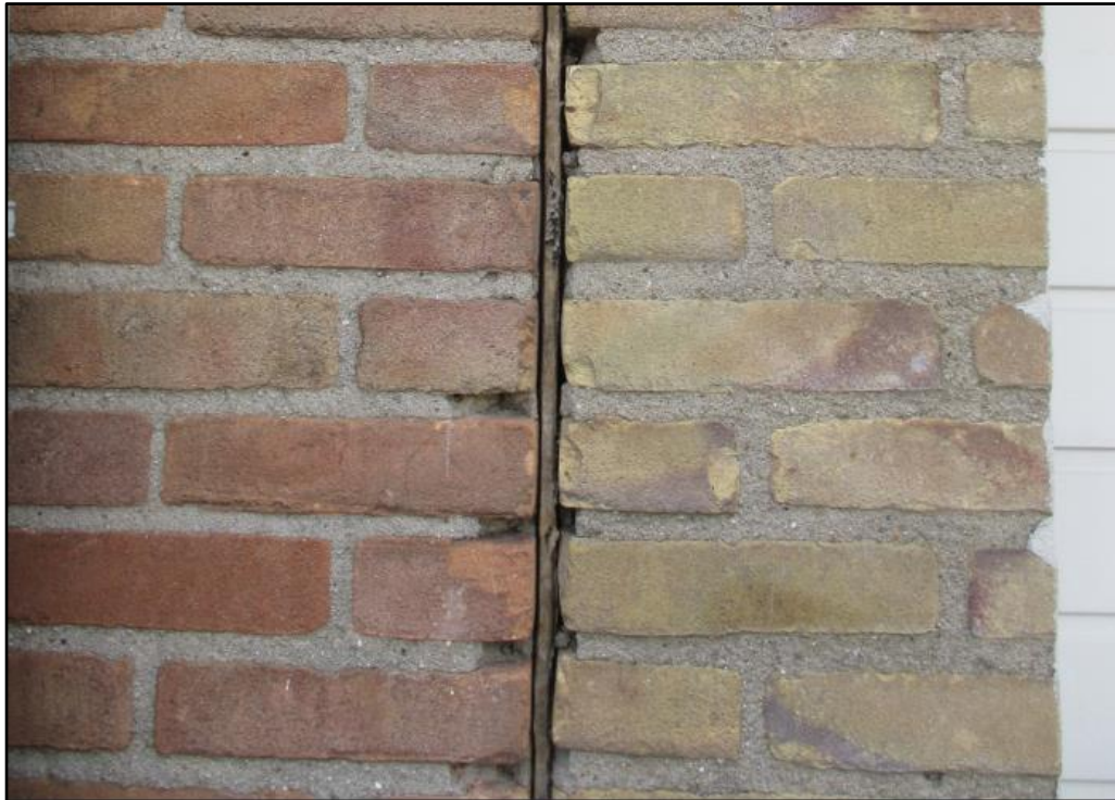
Figuur 1 De gevulde dilatatievoeg in het pand aan de Jan van Galenstraat 4
