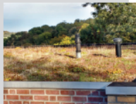
Daken vergroenen Als er weinig ruimte voor groen op de locatie aanwezig is, kunnen de daken van de gebouwen en bergingen uitgeweid worden in vegetatiebedden. Groen zorgt voor minder opwarming en een betere waterregulatie en stimuleert de biodiversiteit.
