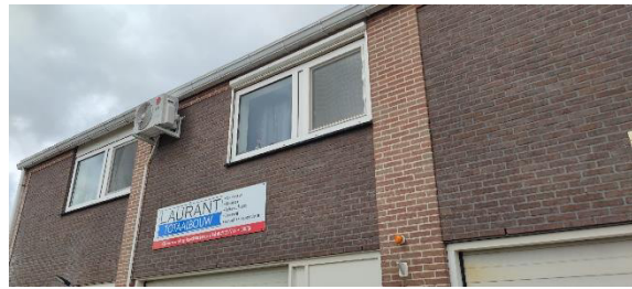
Foto 3.2: Voorgevel woning 1 e verdieping
