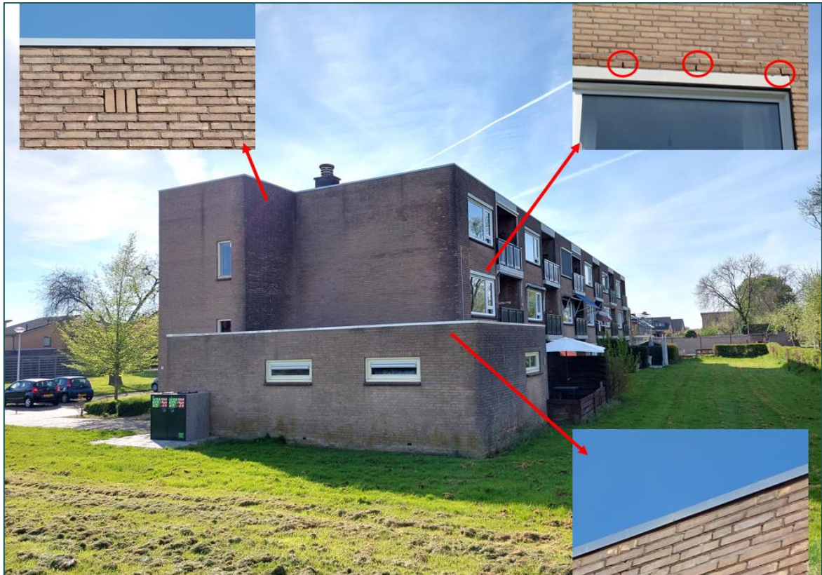
Figuur 3.1 Zowel het bestaande appartementencomplex als de fietsenberging (zichtbaar op de voorgrond) beschikken over een voor vleermuizen toegankelijke spouwruimte.
