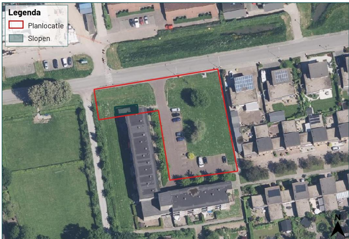
Figuur 1.2 De planlocatie (rood omkaderd) is gelegen aan de Heersweg ong. te Druten. De fietsenberging ten noorden van het bestaande appartementencomplex wordt mogelijk gesloopt. In het midden van de planlocatie zijn de twee te kappen bomen zichtbaar.
