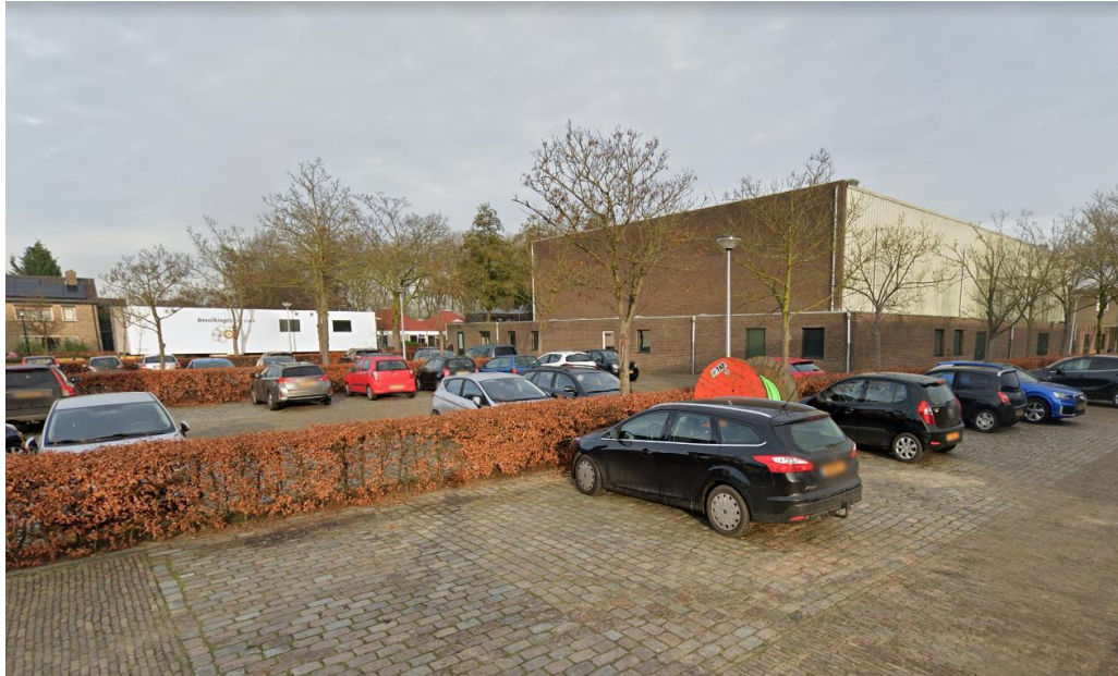
Sporthal en naastgelegen parkeerterrein gezien vanaf de Dijkgraafstraat, bron: maps.google.nl
