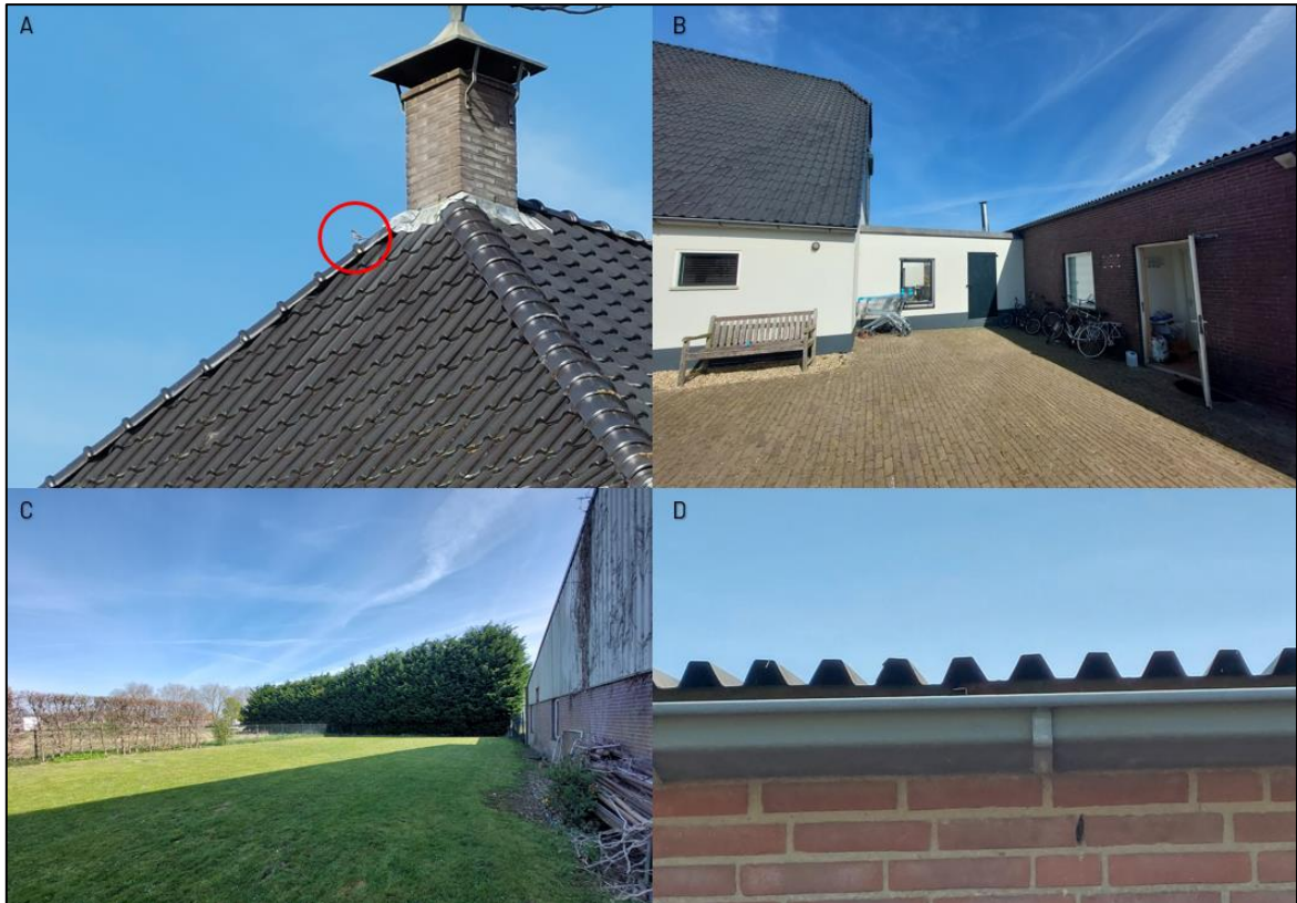
Figuur 3.2 A) Op het dak van de woning direct ten westen van de planlocatie is een huismus waargenomen. B) Links: de woning ten direct westen van de planlocatie; rechts: de te slopen bebouwing. C) Ten noorden van de te slopen bebouwing bevindt zich geen gazon omringd door verschillende hagen (mogelijk functioneel leefgebied van huismus). D) Onder de damwandplaten van de te slopen bebouwing is voldoende ruimte voor huismusnesten.
