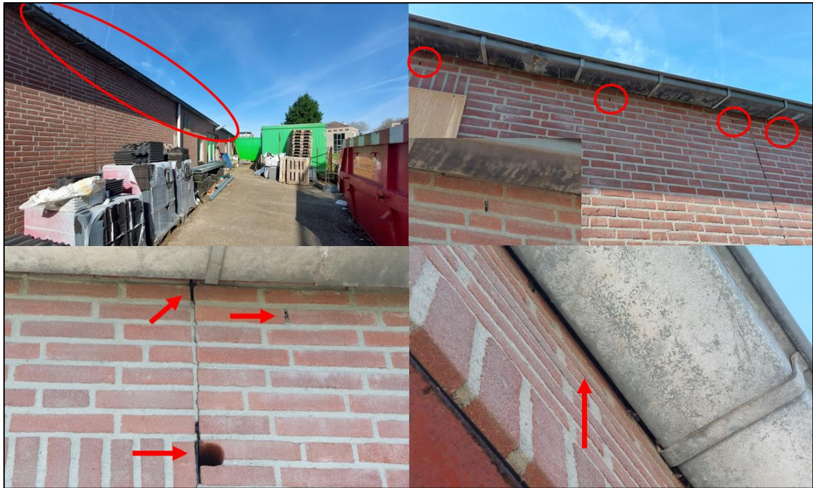
Figuur 3.1 De spouw van de te slopen bebouwing is via verschillende openingen toegankelijk voor vleermuizen.
