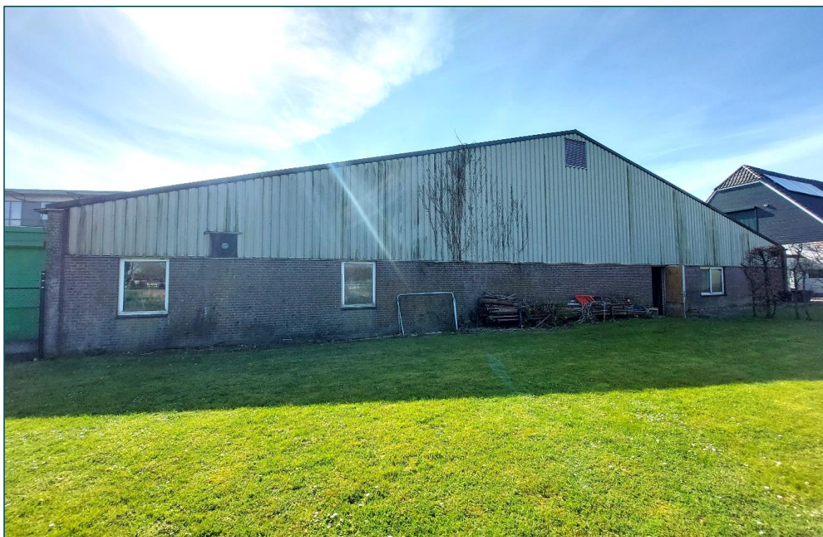
Figuur 2 De bebouwing bestaat uit gemetselde muren met spouw en een damwandplaten dak.
