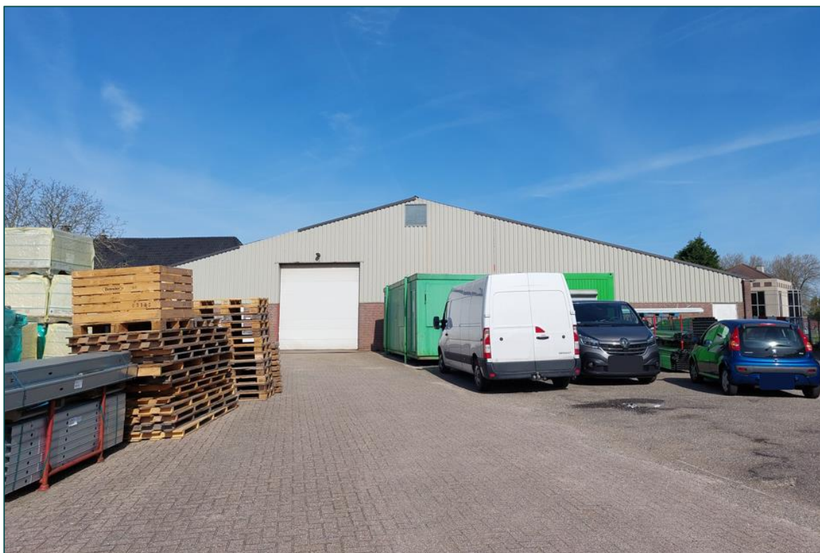
Figuur 1 De planlocatie is gelegen aan de Scharenburg en Klepperheide ong. te Druten en bestaat uit een bedrijfspand/opslagruimte. De beoogde ruimtelijke ingreep betreft de sloop van dit pand ten behoeve van vijf nieuwe woningen.
