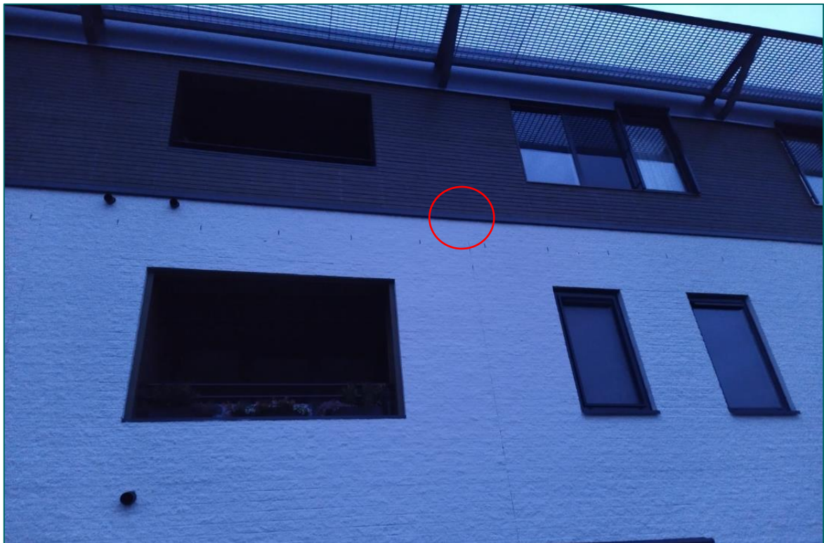
Figuur 3.3 Foto van de vleermuisverblijfplaats (rood omcirkeld) aan de Klepperheide 3A t/m 7K.
