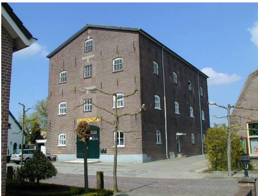
Figuur 7: Tabaksmagazijn, Hooistraat 42
