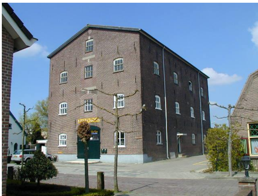
Figuur: tabaksmagazijn, Hooistraat 42
