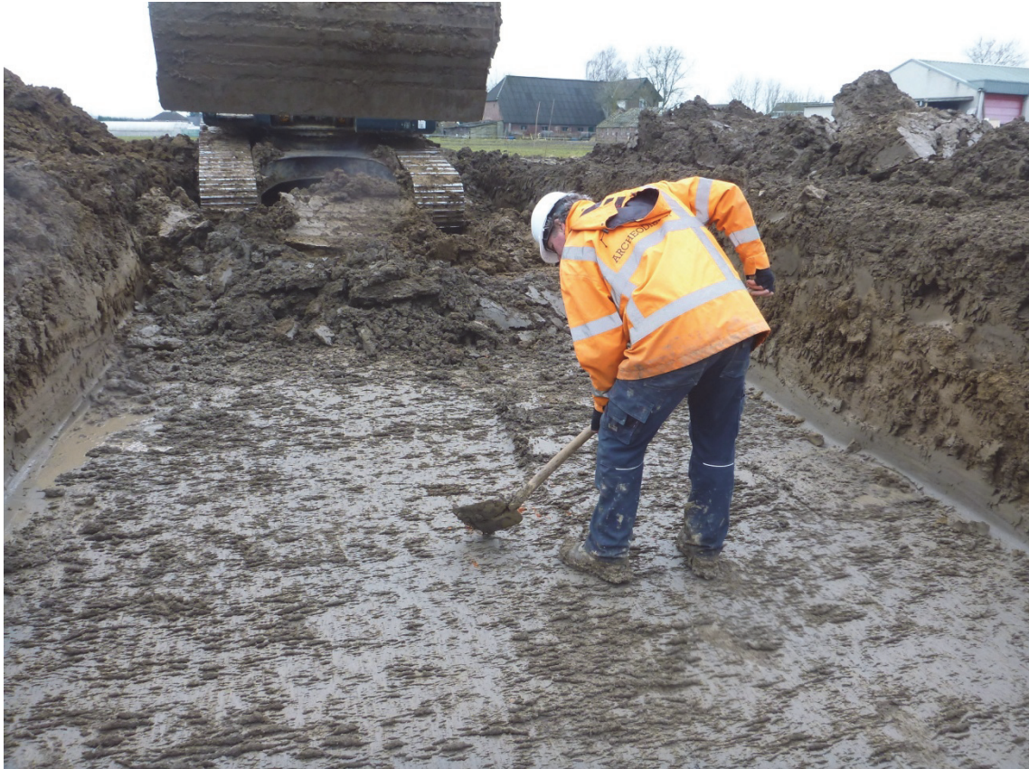
Fig. 4.1: De aanleg van het vlak.
