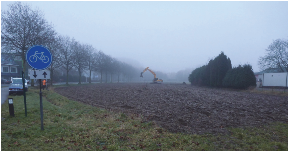
Fig. 3.1: Het plangebied bij aanvang van de werkzaamheden (foto genomen in oostelijke richting). Links de Koningstraat.
