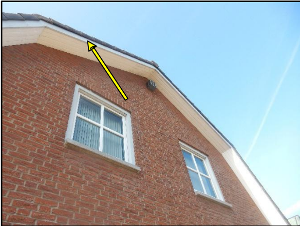
Figuur 10. Geschikte toegangsmogelijkheden voor gierzwaluw aan kopse kanten van het kantoorpand.
