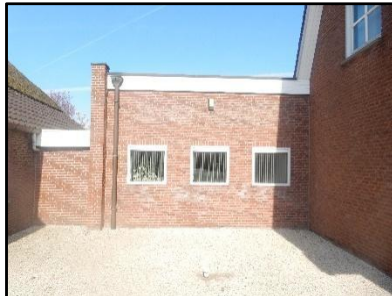
Figuur 4. Aanbouw aan zuidwestzijde.
