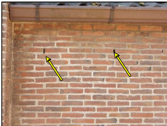
Figuur 11. Geschikte toegangsmogelijkheden voort vleermuizen tot verblijfsmogelijkheden in de spouwmuur.
