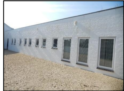
Figuur 5. Aanbouw aan noordzijde.
