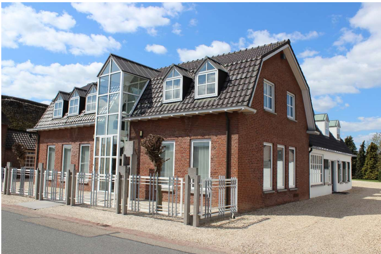
aanzicht van het bedrijfspand aan de Rydjt in Horsens
