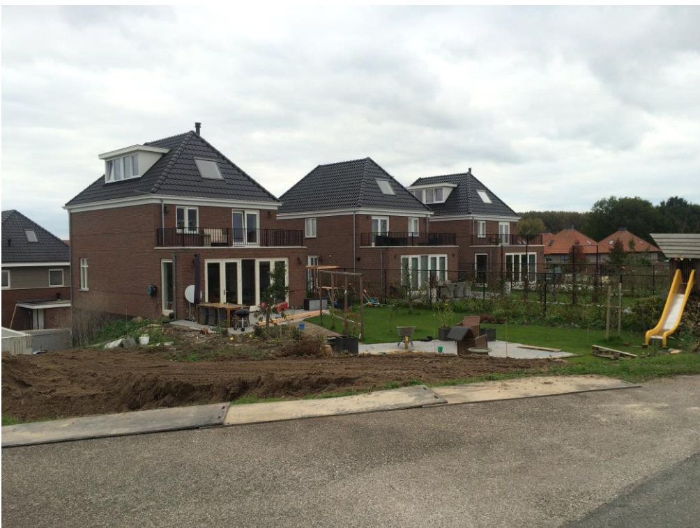
Bestaande woningen ten oosten van het plangebied
