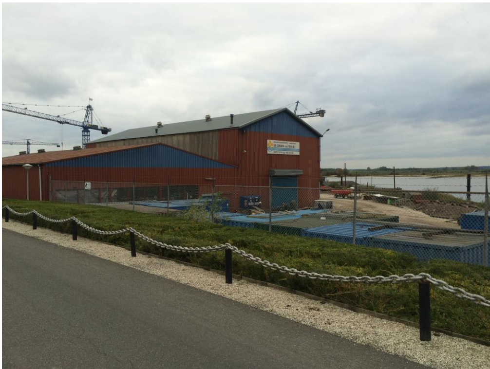
Scheepsbouw- en reparatiebedrijf De Gerlien – Van Tiem B.V.
