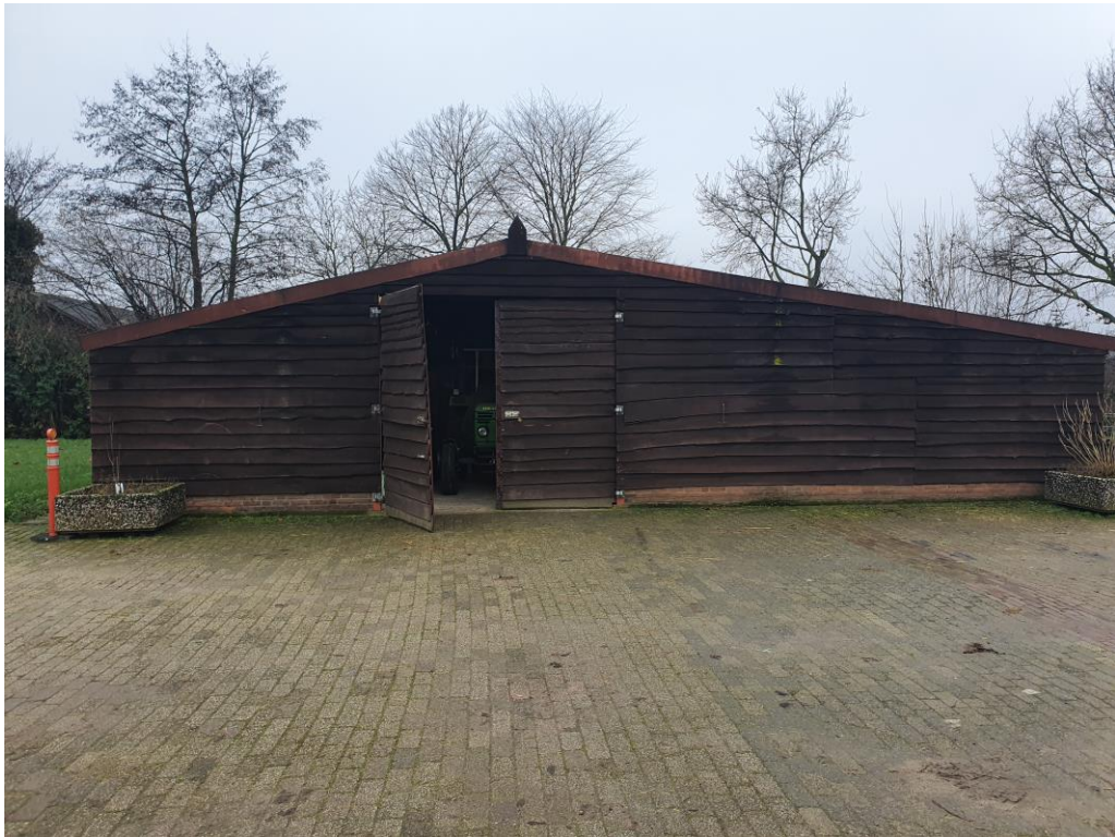
Figuur 1 De te saneren schuur op de planlocatie, opgetrokken uit gemetselde muren en houtenpanelen met een golfplaten dak.
