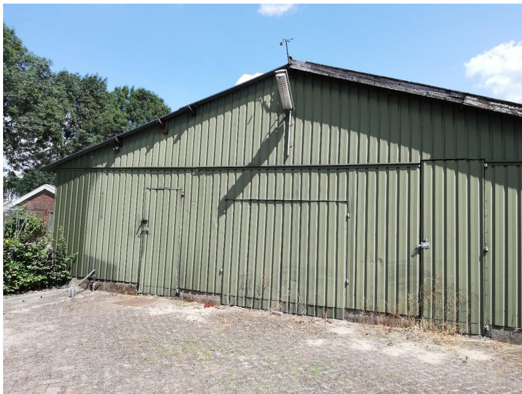
Figuur 1 De planlocatie is gelegen aan de Schriksestraat 26 te Afferden en bestaat uit een schuur opgetrokken uit gemetselde muren, muren met damwandplaten, houten wanden en zadeldak met golfplaten.
