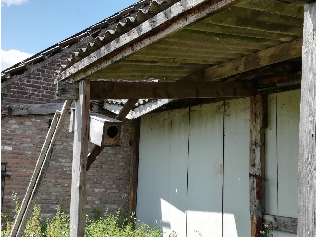
Figuur 3 Oude steenuilenkast aan de schuur. Deze is instabiel en niet in gebruik (zie ook figuur 4).
