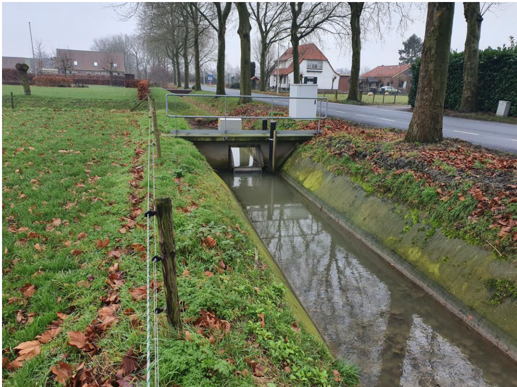
Figuur 4 De watergang tussen de Koningsweg en de planlocatie met steile, betonnen oevers. Deze vallen buiten de planlocatie.
