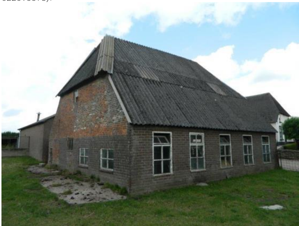
Foto te slopen schuur.
