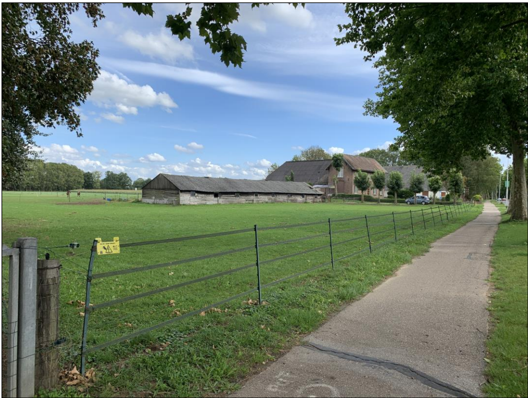
Figuur 2 Impressie van de monumentale woonboerderij met links de te slopen schuur (foto boven) en de te slopen schuur (foto onder).
