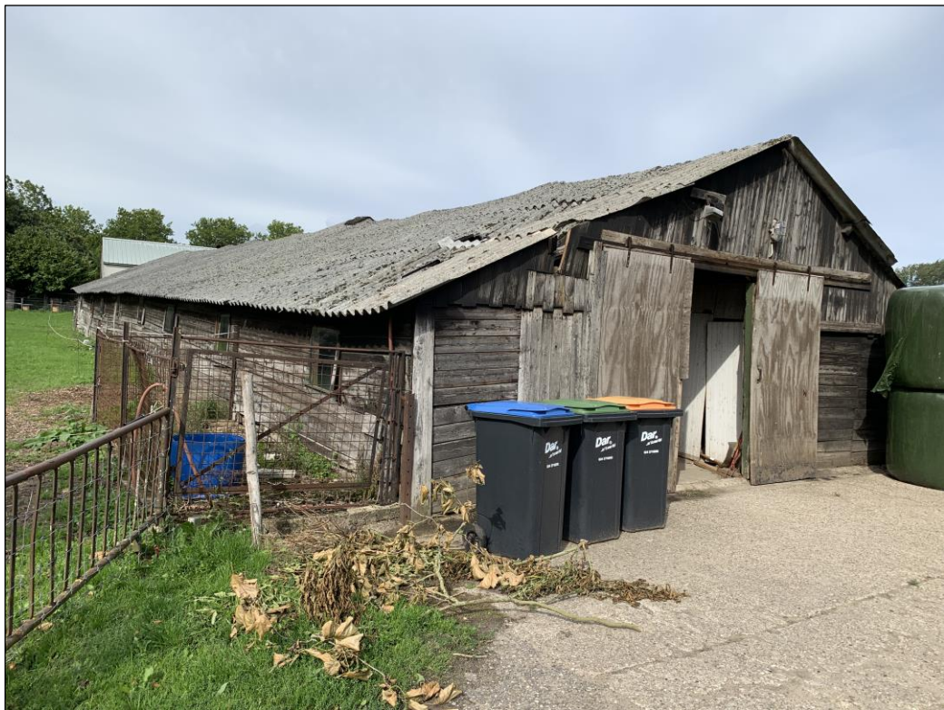
Figuur 6 Op de planlocatie is geen sprake van potentieel geschikte invliegopeningen en verblijfplaatsen van gebouwbewonende vleermuissoorten.
