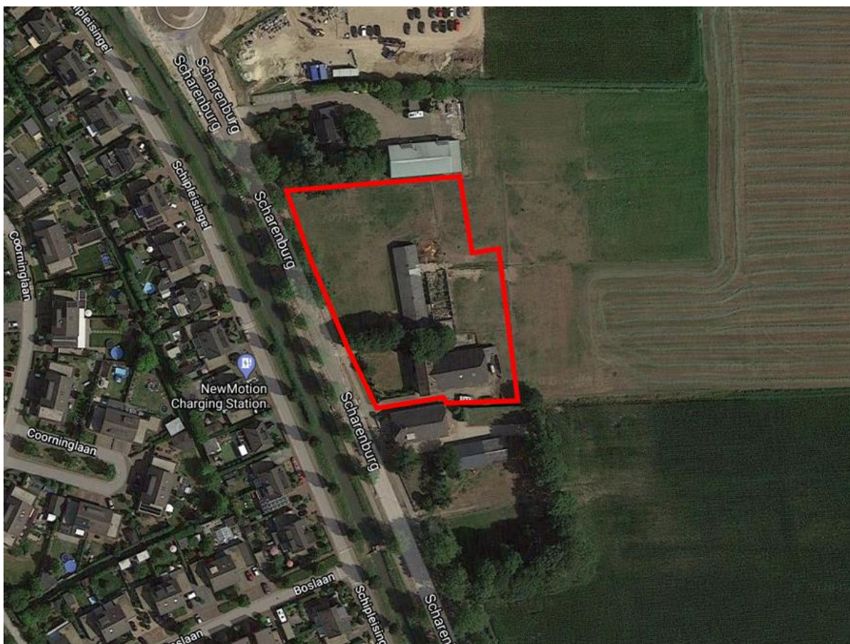
Luchtfoto van het plangebied (bron: Google Maps)
