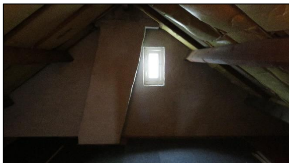
Foto 5. De zolder van de woning
