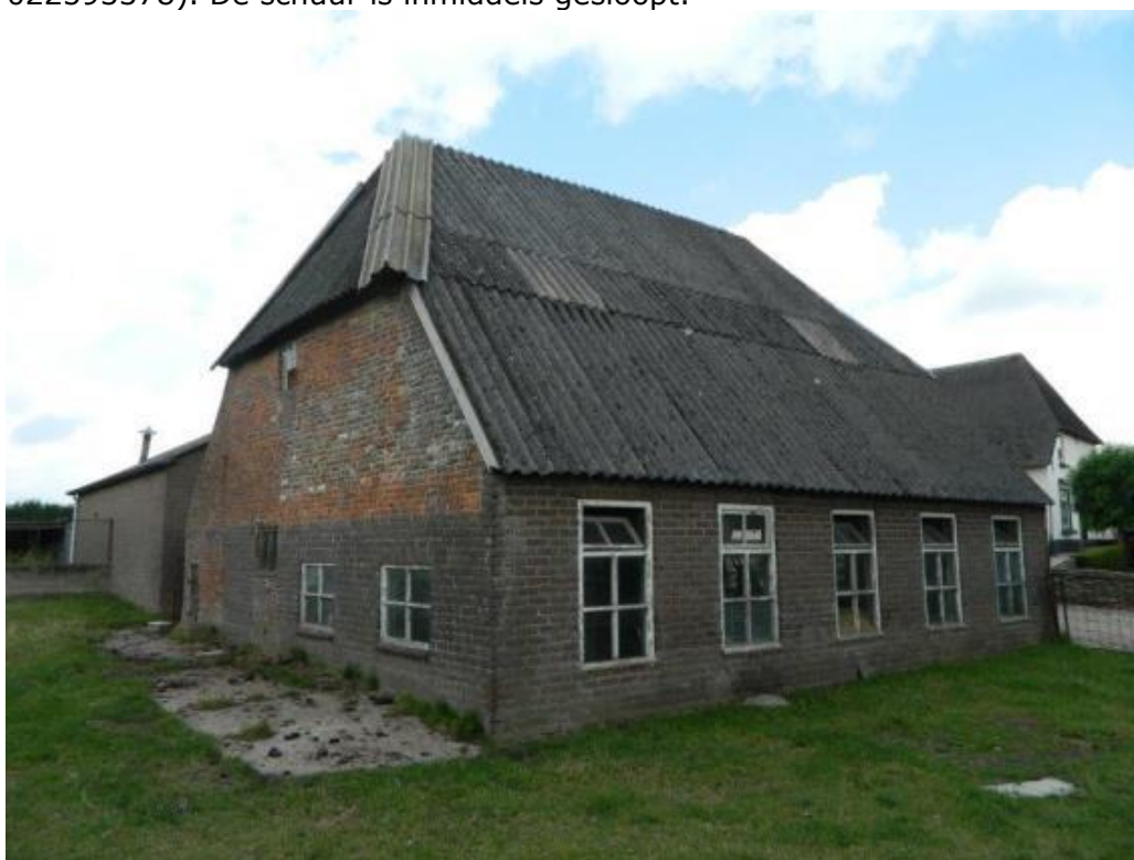
Foto te slopen schuur.
